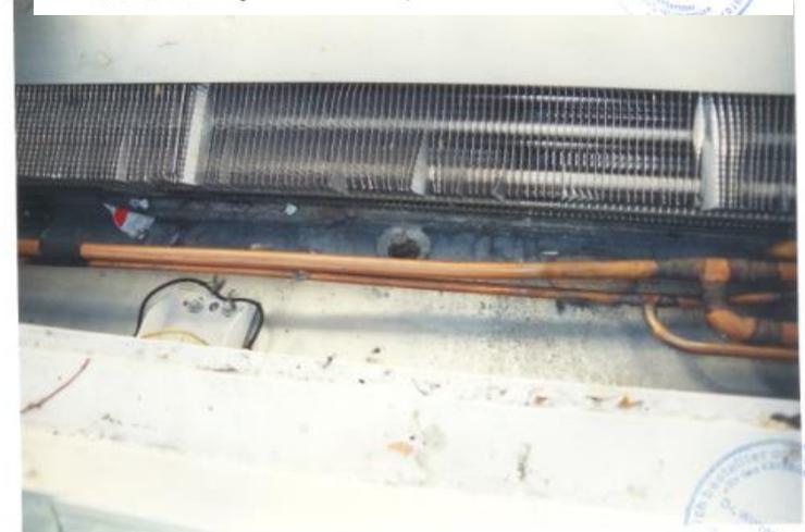
Bild 19a: Detail Korpus 1 innen mit Verdampfer, Kälteleitungen und Tauwasserabfluss
