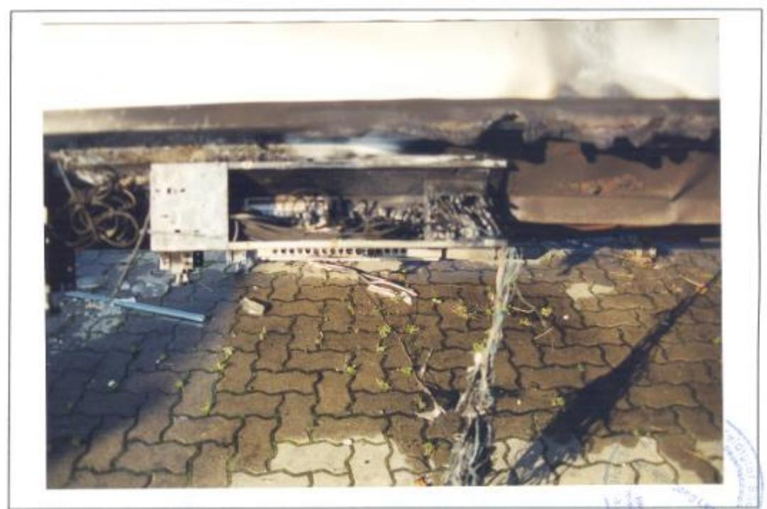
Bild 16a: ausgebrannter Klemmkasten 1, verbrannte Kabelreste, geschmorte Leiste an Korpus 1
